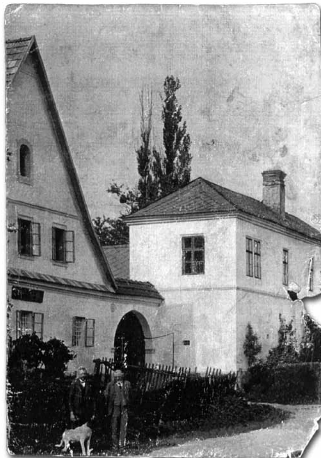
Pohled na dnes již neexistující podobu Schenkhäusel (Šenkovy domky, Hospůdka) u silnice ze Suchdolu nad Odrou do Mankovic. Vlevo vyšší štít hospody (č.p. 62), dole byl sál a horní část byla obytná.
